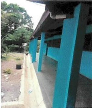
Foto 7: sustitución de canal de alto caudal 0.20 x 0.15 con pendiente de 1.5% en el mismo caudal con presión de 0.80 cm de plana 3/16 x 1 pulgada con bajada de agua
